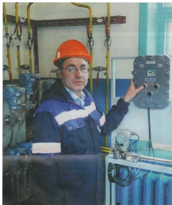
Владимир Окулов и его коллеги подсоединили взрывозащищённый контроллер без проведения огневых работ
