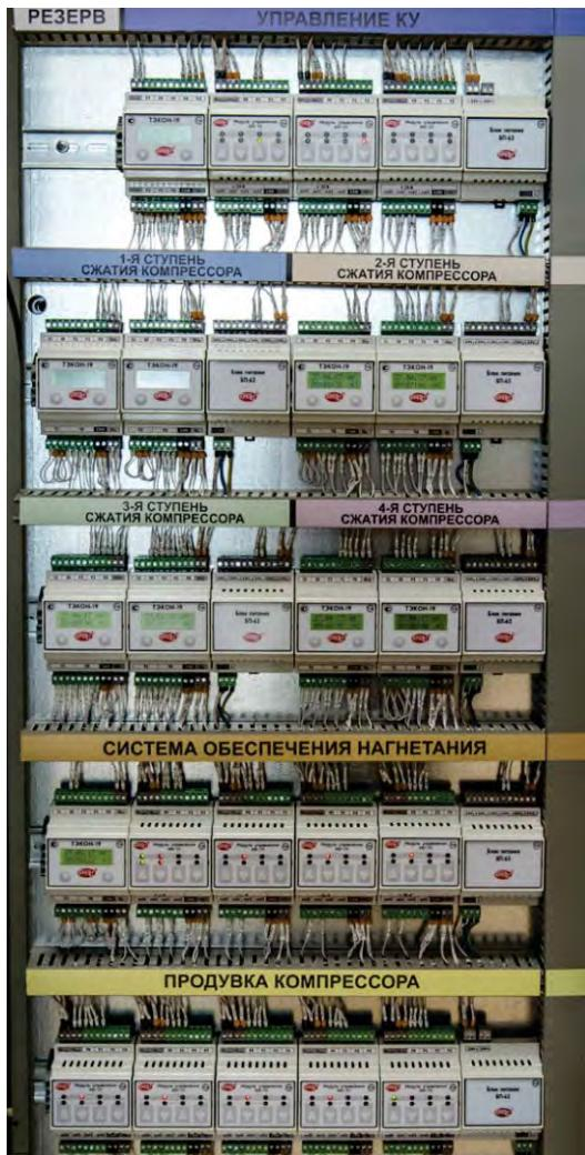
Такая технология построения системы повышает общую отказоустойчивость и существенно упрощает эксплуатацию. Входящий в поставку комплект ЗИП минимизирует время простоя станции при ремонте без существенного увеличения стоимости, поскольку состоит из набора однотипных модулей-ячеек, а не дорогого промышленного компьютера, регламентные работы и ремонт производится силами эксплуатирующей организации без привлечения завода-изготовителя.
